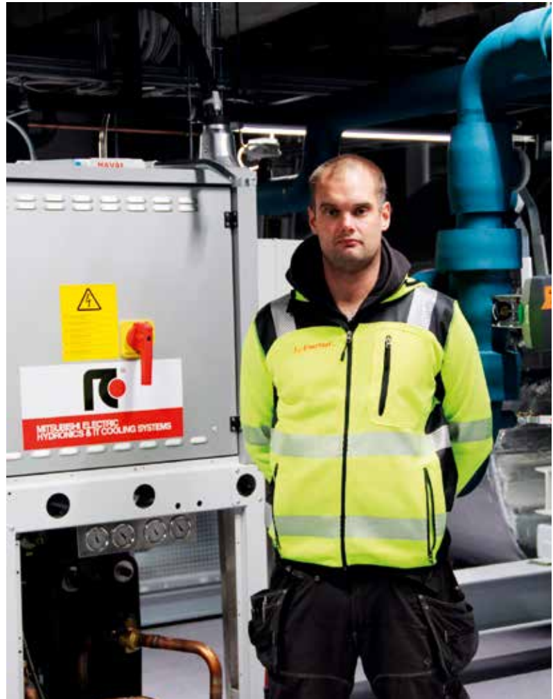
↑ Projektipäällikkö Aleksi Suolahdella riittää käyttöönottovaiheessa työtä, jotta kaikki osatekijät saadaan toimimaan optimaalisella tavalla. Takana toinen lämpöpumpuista.
