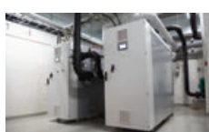
Oilon ChillHeat -teollisuuslämpöpumput Jopa 120 °C-asteisen veden tuottaminen on mahdollista Oilon ChillHeat P-sarjan lämpöpumpuilla
