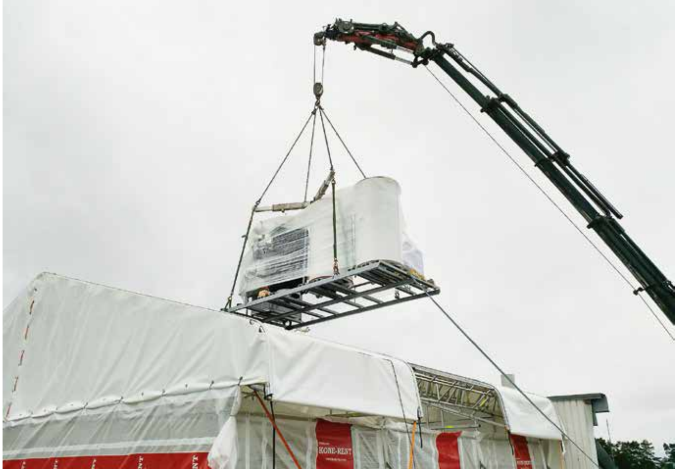
↑ K-Supermarket Runosmäen kattoa avattiin IV-konehuoneen osalta, jotta laitteisto saatiin nostettua sisään. Kuva: Tom Allen Senera Oy.
