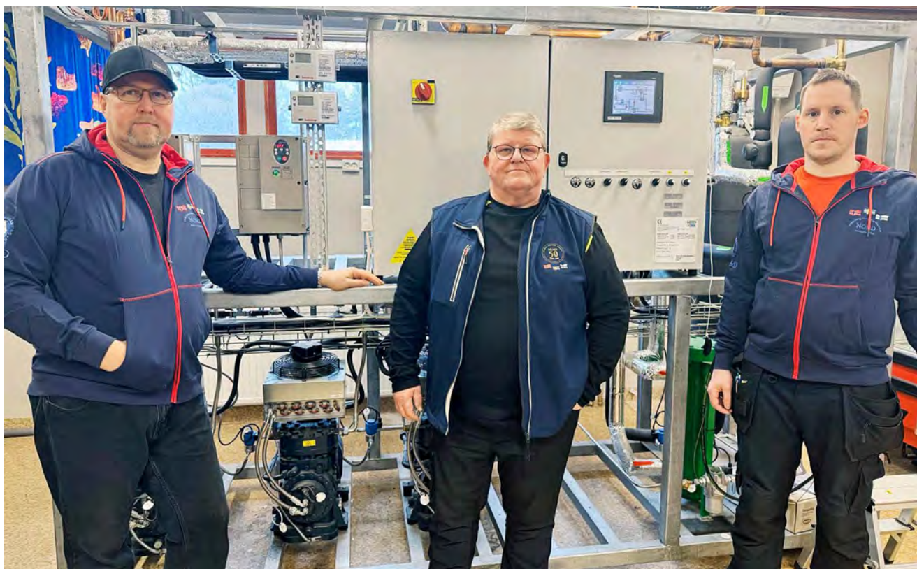
↑ Jyrki Kuusela (vas.) ja Ville Partala (oik.) opiskelevat parhaillaan kylmäteknikkaa Utbildning Nordissa. Keskellä kylmäteknikan opettaja Jukka Kauvosaari. Taustalla oppilaitoksen suurempi CO 2 -laitos.
