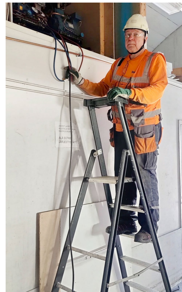
↑ Taisto Tolonen myymäläkylmän purkutöissä Laajasalon Neste K-huoltoasemalla. Kuva: Markus Tolonen.
